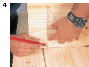
**5. Tracer les emplacements des montants extérieurs, puis les axes des lamellos.**
